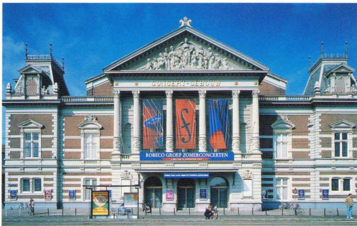
オランダのアムステルダムにあるコンサートホール「コンセルトヘボウ」。ロイヤル・コンセルトヘボウ管弦楽団の本拠地として使用されている。
