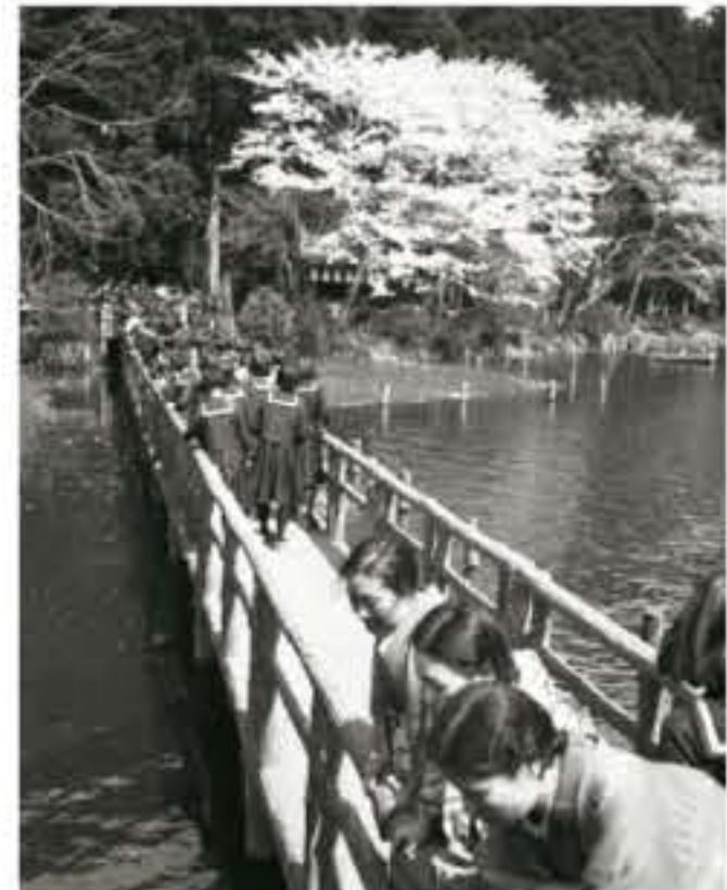
昭和10年代の中の橋。欄干はコンクリートやモルタルの擬木だ。(撮影：徳田東助)
