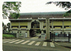
現築地本願寺の和田堀跡
